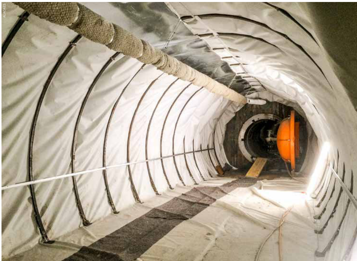
Sicht auf die Auskleidung in unmittelbarer Nähe des Betonpfropfens.
