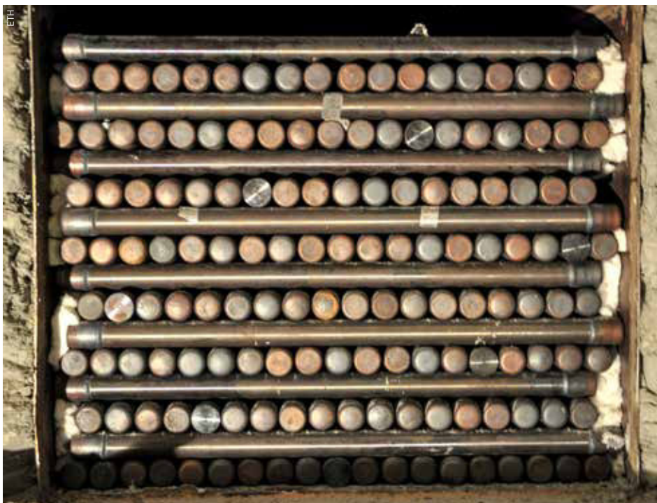
Blick in das Innere des zweiten Wärmespeichers. Die Stahlrohre und das Isolationsmaterial sind sichtbar.
