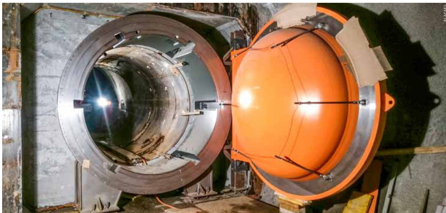
Einer der Betonpfropfen mit Stahltüre, die die Kaverne im Schutterstollen begrenzen.
